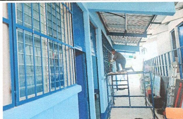
Foto 2: Mejoramiento de pintura a base de aceite en zócalos de módulos de aulas, así como en superficies interiores y exteriores de los servicios sanitarios.
