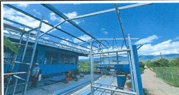
Foto 5: Suministro e instalación de estructura metálica para galería de 7.00 x 12.00 m. conformado por columna de tubo cuadrado, vigas principales y costaneras tipo lámina "YOS", incluyendo correas y herrajes de anclaje.
