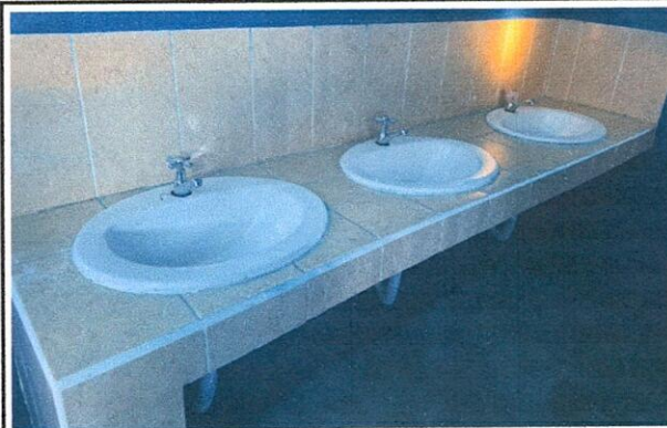
Foto 4: Suministro e instalación de accesorios nuevos para 6 lavamanos, incluyendo llaves, desagües y sifones.
